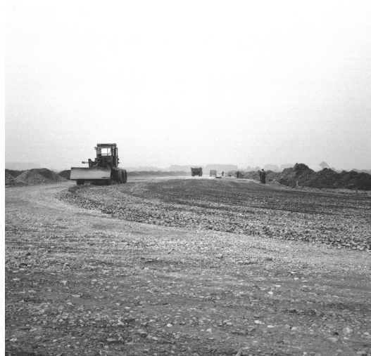
HET AANLEGGEN VAN EEN MAIN RWY
