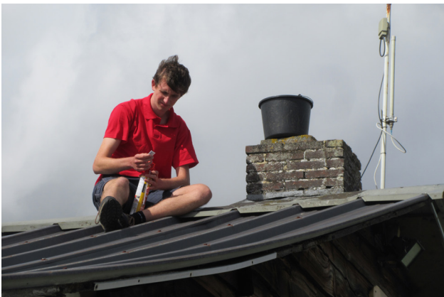
ARTHUR HERSTEL HET DAK
