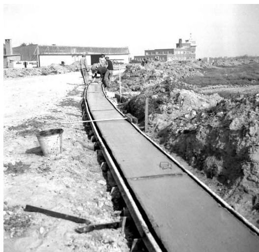
HET AANLEGGEN VAN DE BOORDEN VAN TWY
